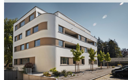
]] Mehrfamilienhaus Bad Säckingen
